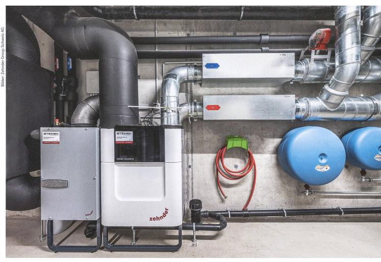
Eine Grundwohnungslüftung schliesst die preisliche und technische Lücke zwischen einer Komfortlüftungsanlage und einer reinen Abluftanlage. Dabei verbindet eine Steigleitung mit der Zu- und Abluft die Wohnungen mit dem Lüftungsgerät im Keller.
