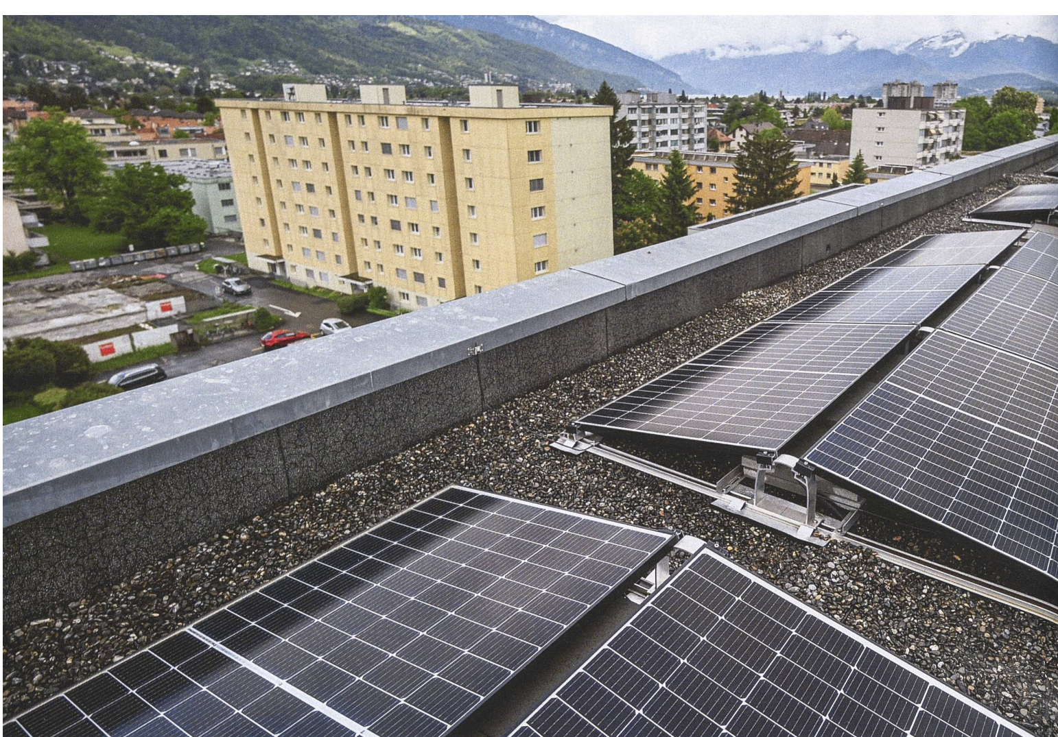
Kraftwerk mit Niesenblick: Die Dachflächen aller fünf Bestandesbauten der Siedlung Nünenen wurden mit PV-Anlagen ausgerüstet. Mit ihnen produziert die BWG Nünenen Solarstrom für den Eigenverbrauch.
