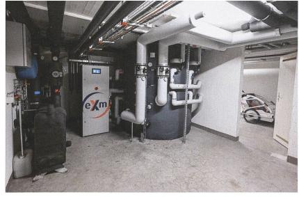
Blick in eine Energiezentrale mit Plattenwärmetauscher, Brauchwasser-Wärmepumpe und Warmwasserspeicher (von links). Nicht im Bild ist die Grundwasser-Wärmepumpe für die Raumwärme.
