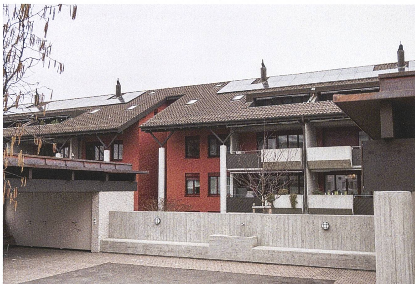
Auf den Dächern der vier Mehrfamilienhäuser findet sich neu eine PV-Anlage mit einer Gesamtleistung von 63,5 Kilowatt-Peak
