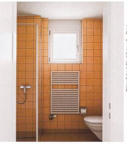
Im Erdgeschoss wurden einige Badezimmer barrierefrei mit schwellenloser Dusche ausgestattet. Die Duschwand lässt sich im Bedarfsfall einfach entfernen. Bei Farben und Plattenformaten hat man sich an die Gestaltung der 1980er-Jahre angelehnt.
