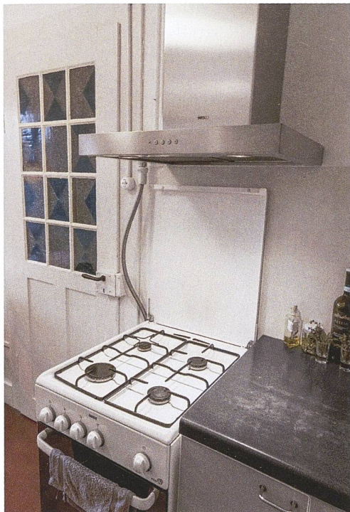
In den Küchen wurden Dampfzüge mit Abluft installiert. Für die Öffnungen in den Fassaden, die dadurch nötig wurden, fand man mit der Denkmalpflege gute Lösungen.
