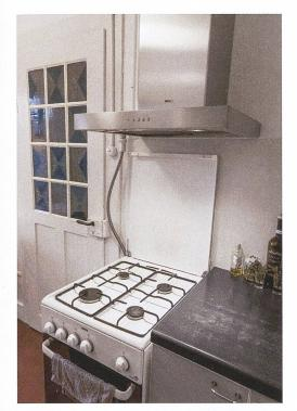
In den Küchen wurden Dampfabzüge mit Abluft installiert. Für die Öffnungen in den Fassaden, die dadurch nötig wurden, fand man mit der Denkmalpflege gute Lösungen.
