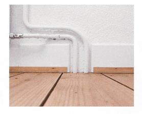
An den Innenwänden sorgen neu atmungsaktive Calciumsilikat-Platten für einen regulierten Feuchigkeitsaustausch. Auch ästhetisch überzeugt die Lösung: Samt Kalkputz ist der Wandaufbau nur drei Zentimeter dick.
