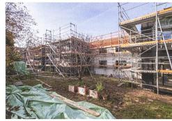
Die Aufbauten ruhen auf je vier Schraubfundamenten. Die dünnen Stahlstützen kommen ohne Betonfundament aus. Weil keine Aushubarbeiten nötig waren, dauerte die Montage nur drei Tage.
