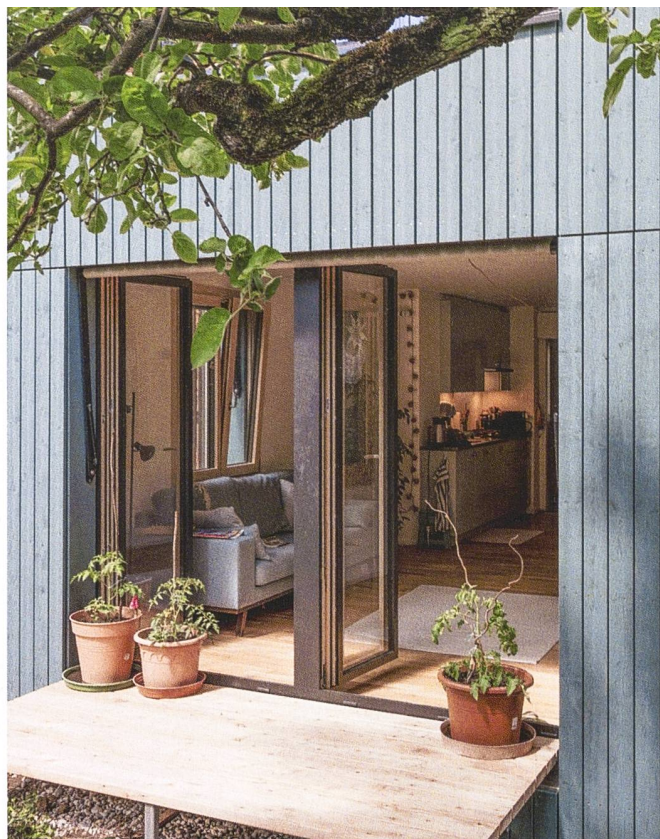
Die zweigeschossigen Anbauten bestehen aus vorgefertigten Holzelementen. Die unteren Wohnungen führen direkt in den Garten, in den oberen Geschossen sorgt nun eine erhöhte Holzdecke für mehr Luft.
