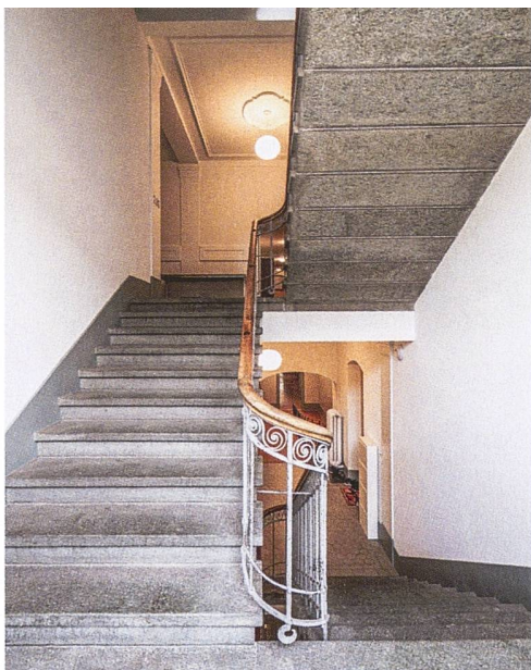
Die geschützten Treppen und Gänge mussten in ihrer Grundstruktur erhalten bleiben und wurden denkmalpflegerisch saniert.
