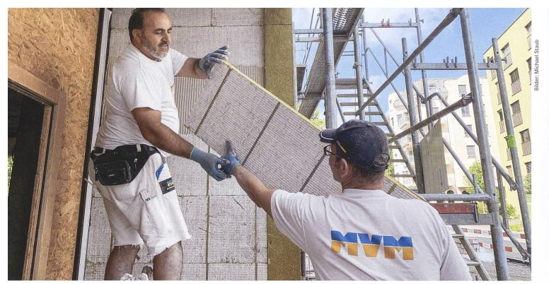
Auch ohne Gesamtsanierung gibt es bei der Gebäudehülle Potenzial für Energieeinsparungen. So sollten Fenster, Dach, Estrichboden und Kellerdecke geprüft und ersetzt oder nachgedämmt werden.
