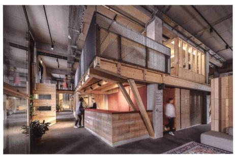
nicht geklebt, sondern verschraubt oder mit Bolzen befestigt. Sämtliche Ressourcen sollen nämlich später wieder in einen natürlichen Kreislauf zurückgeführt werden können. Die Betreibergenossenschaft fördert die Ziele der Nachhaltigkeit und Zirkularität auch nach Fertigstellung des Gebäudes. Bereits heute arbeiten Startups aus verschiedenen Wirtschaftsbereichen im CRCRL-Haus an neuartigen und nachhaltigen Lösungen, beispielsweise zu Abfallvermeidung oder Ressourcenschonung.
