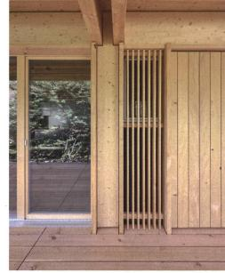
Mehr als ein Drittel des verbauten Holzes ist unverleimtes Massivholz aus der Region.
