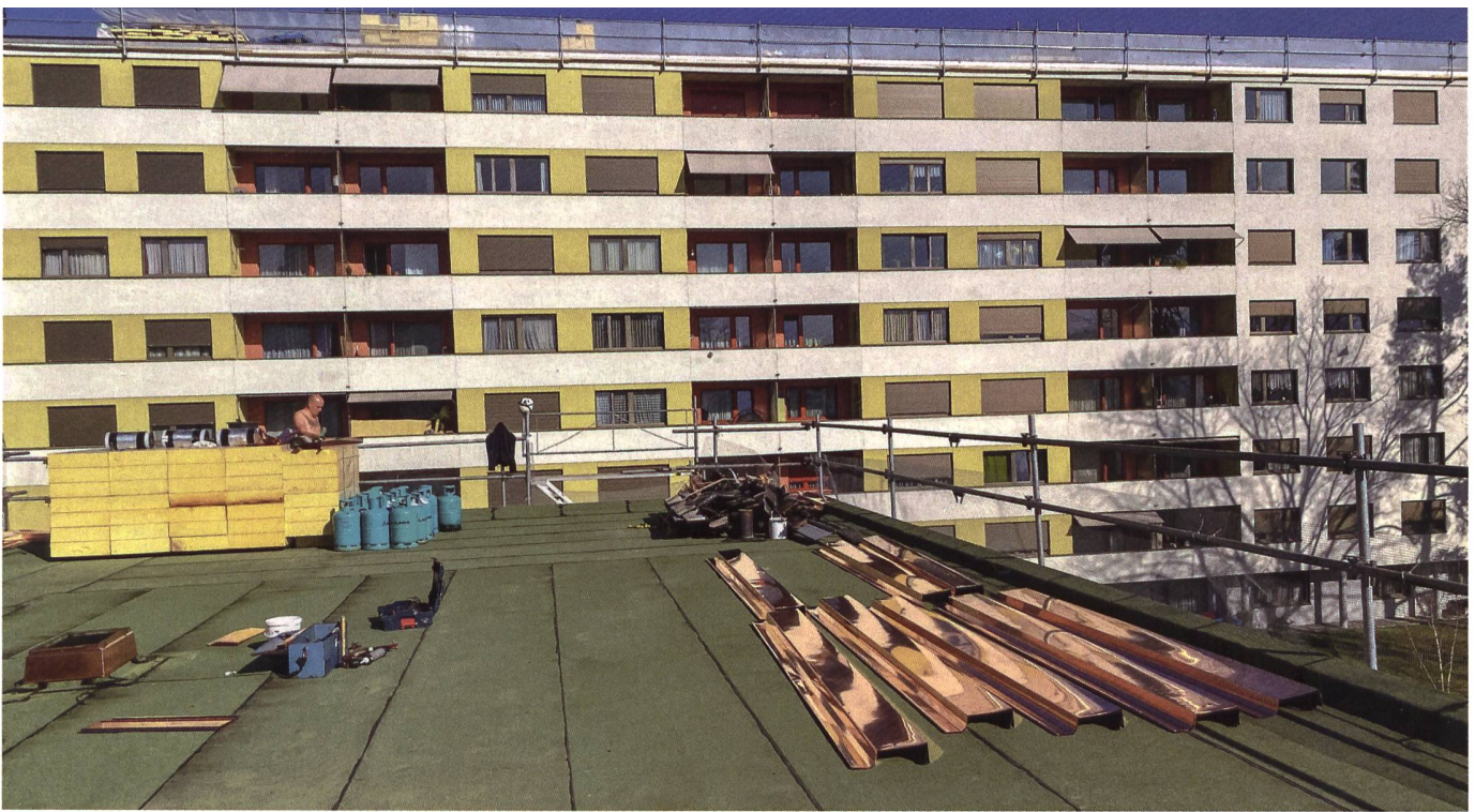
Die drei 1960er-Jahre-Gebäude der Gewobag-Siedlung Frankental in Zürich Höngg wurden vor gut zwanzig Jahren erneuert. Da mittlerweile bei den Flachdächern aber Wasser in die Dämmung eingedrungen ist, war eine erneute Sanierung erforderlich.
