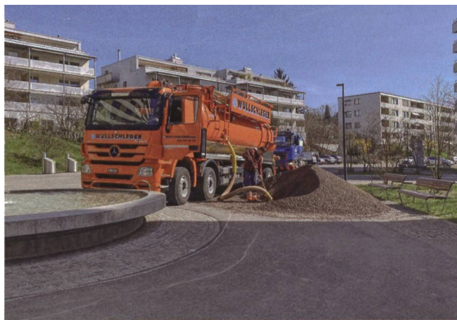
Flachdachsanierungen stören den Alltag der Mietenden kaum. Das Absaugen und Hochblasen der Schutz- und Nutzschicht verursacht allerdings Lärm.
