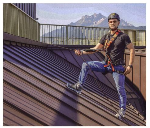
Wer ein «Gstältli» – die «Persönliche Schutzausrüstung gegen Absturz» (PSAgA) mit Auffanggurt und Seil – nutzt, hat für die korrekte Handhabung Kurse und Prüfungen zu absolvieren.
