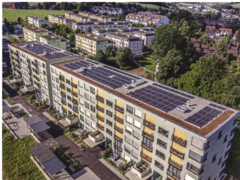
Die Fotovoltaik-Anlage auf dem Dach der Überbauung Papillon im bernischen Niederwangen liefert den grössten Teil des benötigten Stroms. Alle Wohnungen sind einer Eigenverbrauchsgemeinschaft angeschlossen, über welche die Mieter von günstigen Konditionen profitieren.
