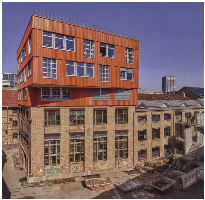
So geht klimataugliches Bauen: Auf dem ehemaligen Sulzerareal in Winterthur hat die Stiftung Abendrot die Halle 118 mehrheitlich mit gebrauchtem Baumaterial aufgestockt. 60 Prozent der Treibhausgasemissionen und 500 Tonnen Primärmaterialien konnten so im Vergleich zu neuen Teilen eingespart werden.
