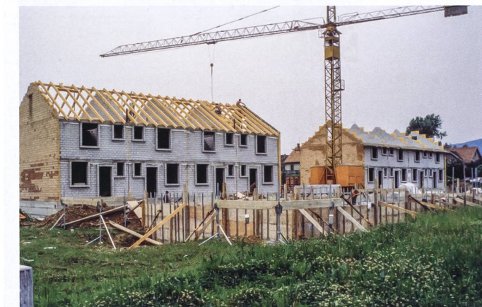
Identische Grundrisse und ein tiefer Ausbaustandard sorgen für einen kostengünstigen Bau. Damit konnten sich auch Arbeiterfamilien die Miete eines Reihenhauses leisten. Oben die Siedlung ganz zu Beginn (undatierte Aufnahme).
