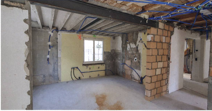
Die Sanierungen erfolgen im unbewohnten Zustand und deshalb etappiert; den Bewohnenden stehen vier Ausweichwohnungen zur Verfügung. Oben Umbau der Wohnküchen, rechts Anlegen neuer Sickerleitungen.
