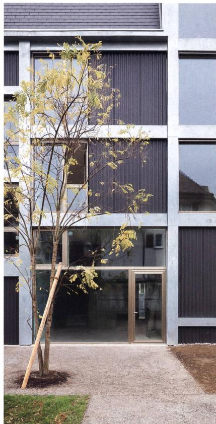
**Faserzement der Eternit (Schweiz) AG wurde auf dem Dach, sowie gewellt als Fassadenhülle eingesetzt.**
