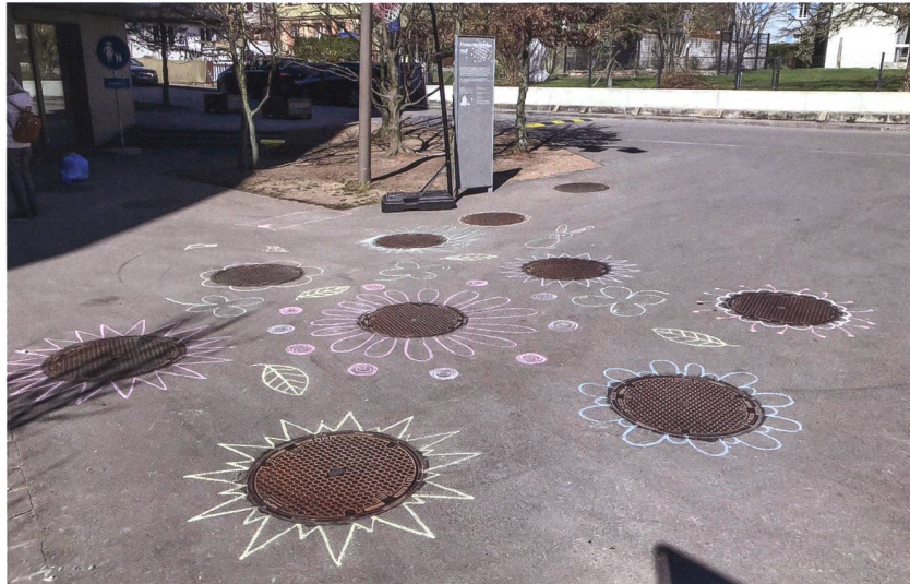
Unter einem Wendepunkt wurden auf einer Fläche von 60 Quadratmetern acht Bioreaktoren eingelassen. In ihnen wird das Grau- und das Schwarzwasser aus 50 Wohnungen, zwei Kita-Gruppen und einem Bistro gereinigt.
