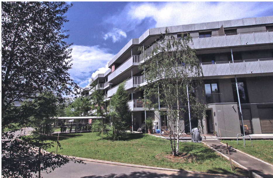
Stöckacker Süd ist nicht nur in Sachen Wasseraufbereitung Pionierin; die Siedlung ist auch das erste 2000-Watt-Areal im Kanton Bern und erfüllt die Nachhaltigkeitskriterien von Minergie-P-Eco.
