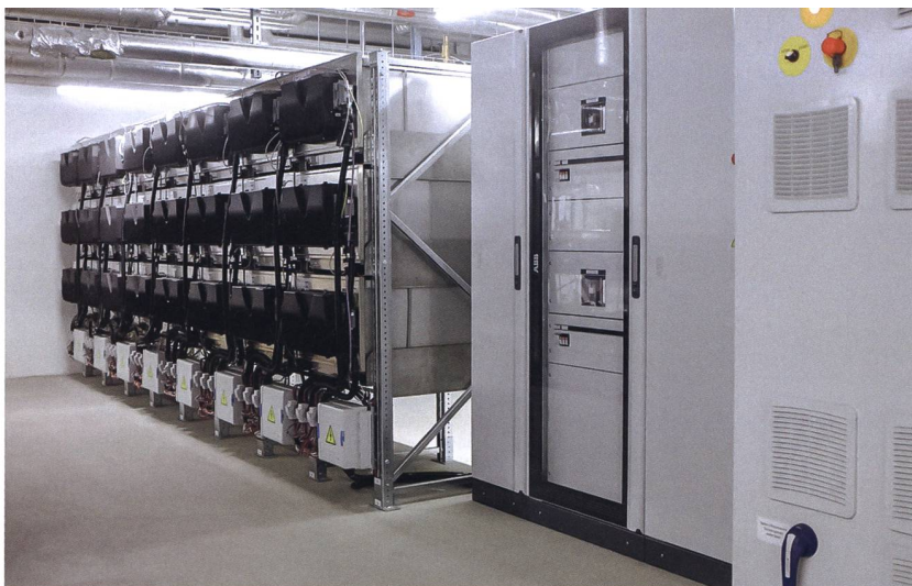
Salzschnelzebatterien sind breit einsetzbar, auch in Wohngebäuden. Sie sind sicher und zuverlässig, derzeit aber teurer als Lithium-Ionen-Batterien (im Bild die derzeit grösste Anlage der Schweiz mit 22 Batterien in der Migros-Filiale Schlieren [ZH]).
