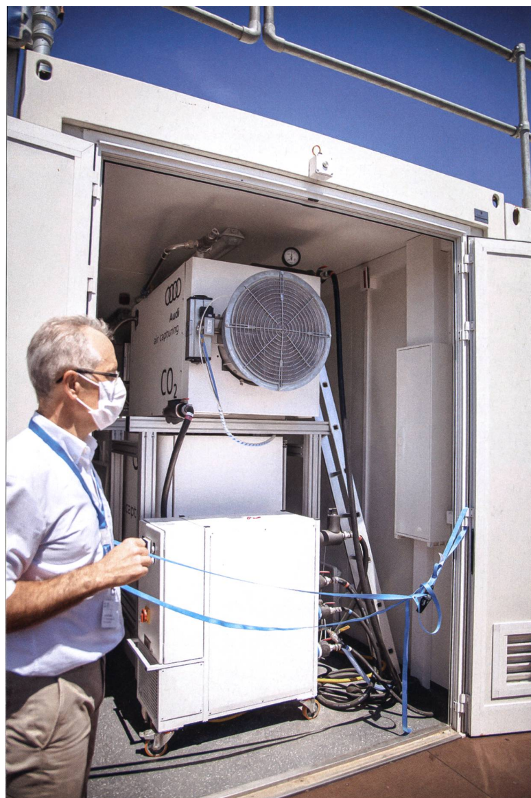
Bei der «Power to Gas»-Technologie wird aus Solarstrom Gas erzeugt und gespeichert. Bisher fast nur in Industrieanlagen im Einsatz, wird sie in Pilotwohnprojekten der Stiftung Umwelt Arena Schweiz, etwa in Männedorf (ZH), erprobt (links: CO 2 -Entnahme aus der Luft, oben Hybridbox).
