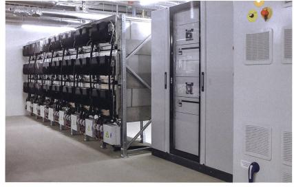
Salzschmelzebatterien sind breit einsetzbar, auch in Wohngebäuden. Sie sind sicher und zuverlässig, derzeit aber teurer als Lithium-Ionen-Batterien (im Bild die derzeit grösste Anlage der Schweiz mit 22 Batterien in der Migros-Filiale Schlieren [ZH]).
