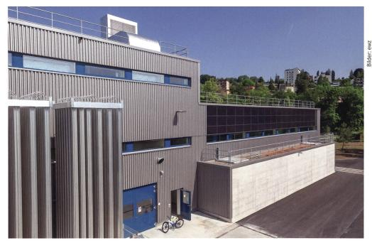
Energiezentrale ewz mit den technischen Anlagen für den Tausch von Wärme und Kälte. Genutzt wird die Abwärme aus gereinigtem Abwasser und aus der Verbrennung von Klärschlamm.
