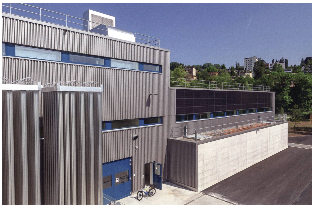
Energiezentrale ewz mit den technischen Anlagen für den Tausch von Wärme und Kälte. Genutzt wird die Abwärme aus gereinigtem Abwasser und aus der Verbrennung von Klärschlamm.
