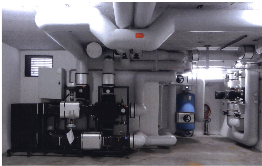
Die neue Wärmeübergabestation (Wärmetauscher) bei der Gewobag.
