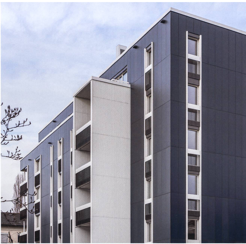
Bei der Planung setzte die Graphis nicht auf maximalen Solarertrag, sondern auf eine gute Gestaltung und Funktionalität. Die dunklen Module setzen sich deutlich von den hellen Fensterkolonnen ab.
