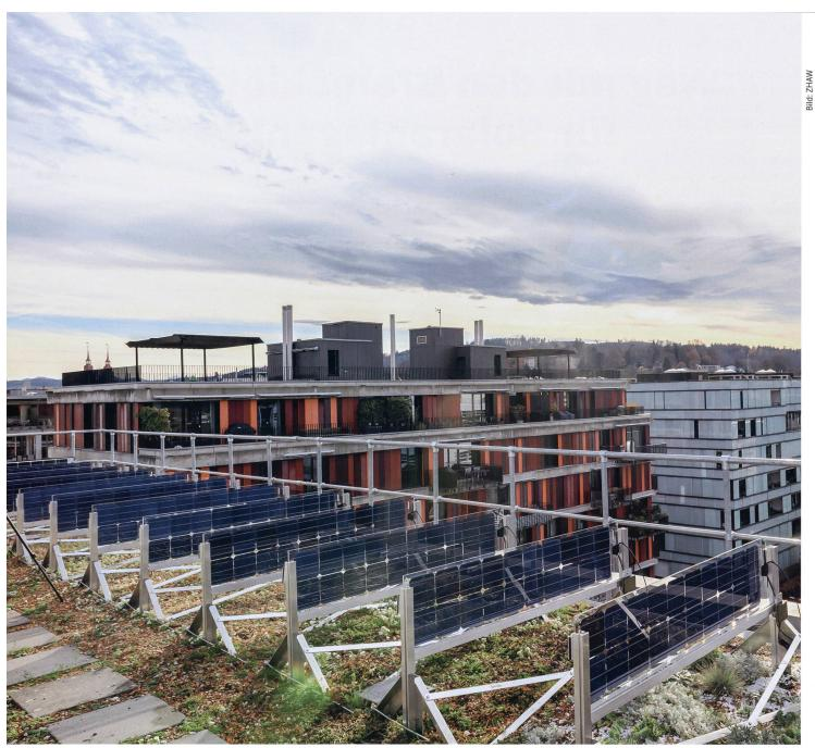
Senkrechte Solarmodule an Fassaden oder auf dem Dach werden künftig eine wichtige Rolle spielen. Sie ermöglichen über den Tagesverlauf und die Jahreszeiten gleichmässigere Solarerträge. Ein Pilotprojekt der ZHAW in Winterthur (Bild) hat überdies gezeigt, dass Pflanzen auf Dächern gut neben vertikalen Solaranlagen gedeihen und dass helle Bepflanzungen den Stromertrag erhöhen.
