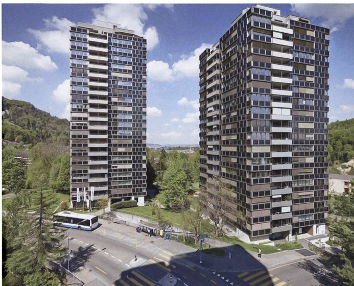
Die beiden Hochhäuser Sihlweid der Baugenossenschaft Zurlinden in Zürich Leimbach wurden bei einer Sanierung 2013 mit PV-Fassaden ausgestattet. Urs Muntwyler hat mit Messungen beim Pionierprojekt aufgezeigt, dass eine vierseitig orientierte PV-Hülle einen gleichmässigeren Ertrag erbringt.
