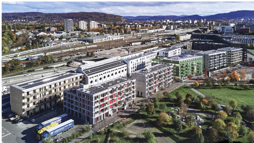
Die Bauten im Quartier Erlenmatt Ost in Basel sind zur bisher grössten Eigenverbrauchsgemeinschaft der Schweiz verbunden. Photovoltaik auf den Dächern liefert Strom für die Wärmepumpen und deckt einen Teil des übrigen Strombedarfs.
