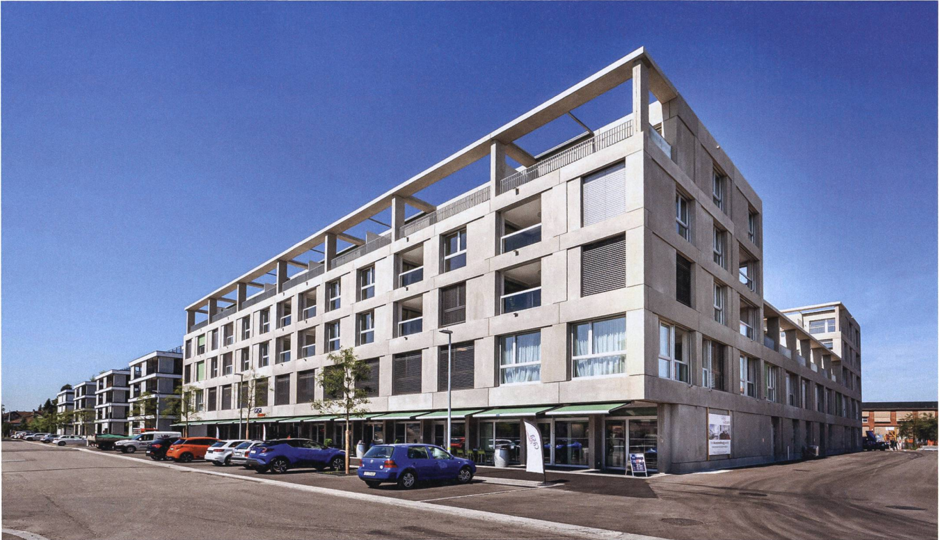
Die Casa Giesserei bietet Alterswohnraum mit Dienstleistungen. Im Hintergrund links die Siedlung Parkside.
