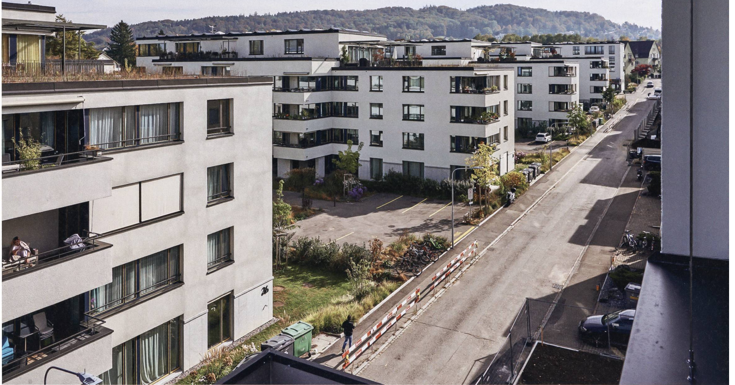
260 Neubauwohnungen hat die Baugenossenschaft Frohheim am Brüderhofweg (Bild) und an der Anna-Heer-Strasse erstellt.
