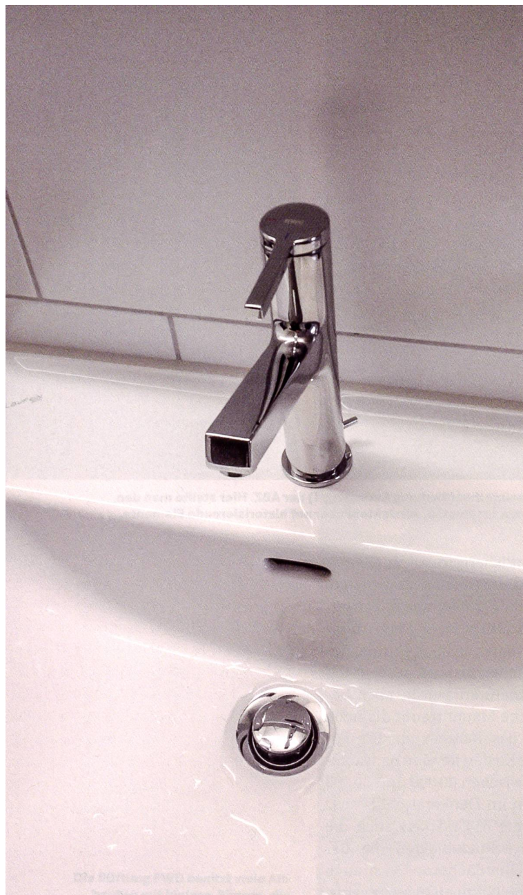
Armatur mit Funktion «Mittelstellung kalt» in kalter Stellung (links) sowie in warmer Stellung.
