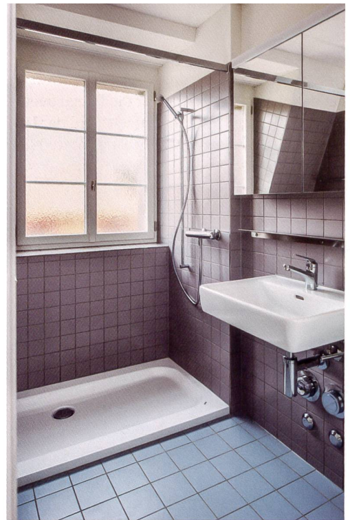
Die BEP achtet bei der Badsanierung auf die Bedürfnisse der älteren Mieterschaft. Bis zu einer Wohnungsgrösse von dreieinhalb Zimmern baut sie in der Regel Duschen statt Wannen ein. Ein mehrflügler Spiegelschrank sorgt für Stauraum (Bilder: renoviertes Bad in der Siedlung Letten 4, Imfeldstrasse, Zürich).
