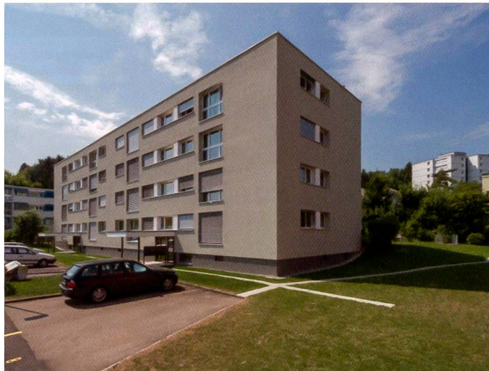
Gesamtsanierung MFH Am Brunnenbächli in Zollikerberg
