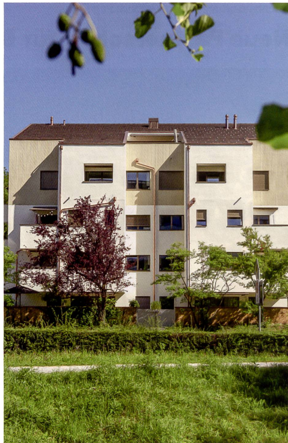
Die Siedlung Weissshau nach der Sanierung: Mit der Aufstockung konnten 22 Wohnungen hinzugewonnen werden.
