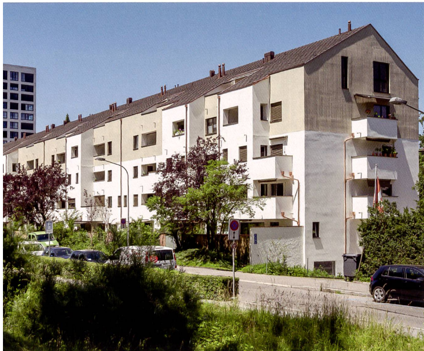
Die Siedlung Weissshau nach der Sanierung: Mit der Aufstockung konnten 22 Wohnungen hinzugewonnen werden.
