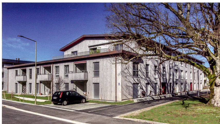
Das jüngste Neubauprojekt der Aktiengesellschaft für Erstellung billiger Wohnhäuser in Winterthur: Die Siedlung Mattenbach mit vier Häusern und 76 Wohnungen ist weitgehend aus vorgefertigten Holzelementen gefertigt.
