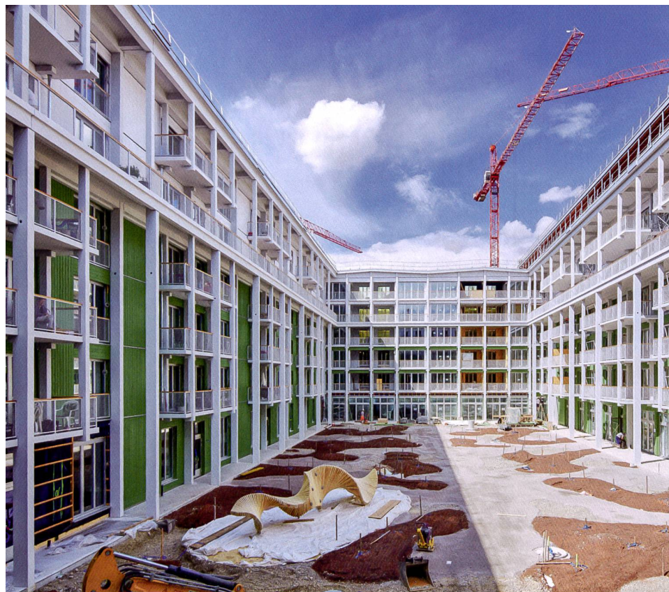
Ein Grossteil des Gemeinschaftslebens wird im 2000 Quadratmeter grossen Innenhof stattfinden. Hier ist ersichtlich, dass der Bau zu grossen Teilen aus vorgefertigten Holzelementen besteht.
