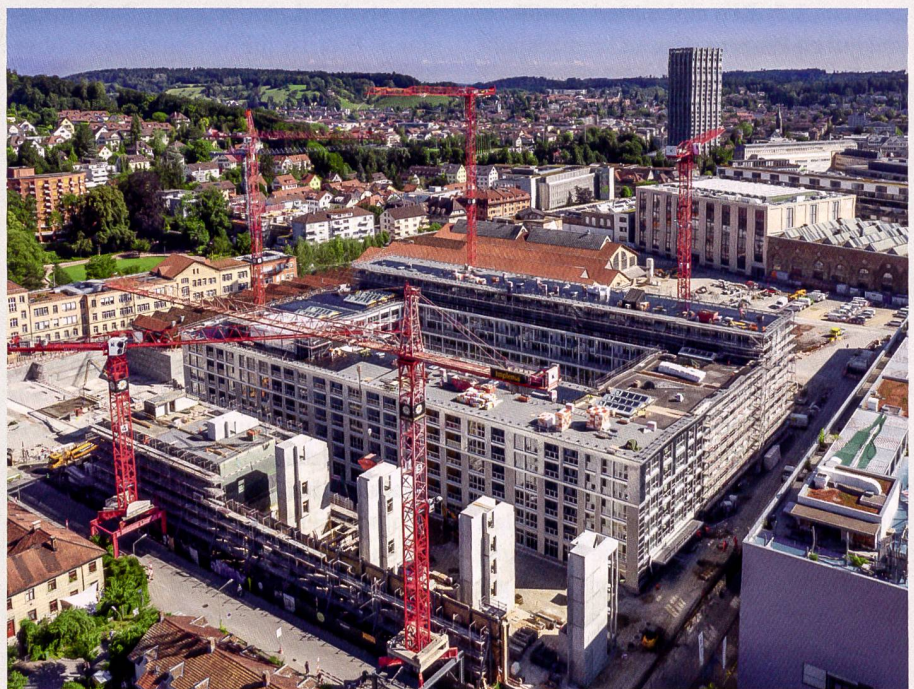
Lokstadt-Baustelle im Juni 2020: Als erstes Haus wird das «Krokodil» fertig.
