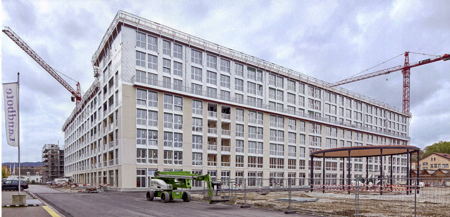
106 Meter lang, 65 Meter breit, bis zu acht Geschosse: der Neubau «Krokodil» in der Winterthurer Lokstadt, die in den nächsten Jahren entsteht. Rechts grenzt die noch leere Fläche des künftigen Dialogplatzes an.
