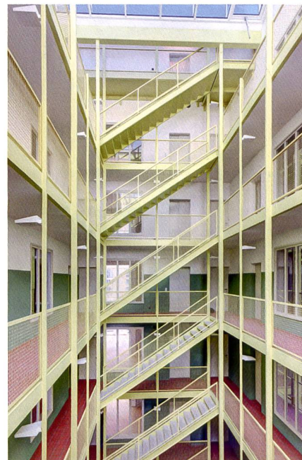
An die Eingangshalle schliessen zwei Lichthöfe an, wo sich die Treppenhäuser mit den Wohnungszugängen befinden.
