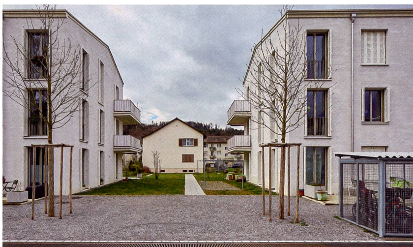
In den letzten Jahren sind auch in den Winterthurer Genossenschaftsquartieren erste Ersatzneubauten entstanden: so im Quartier Mattenbach die Siedlung Zwingli-strasse der Baugenossenschaft Talgut (2018).
