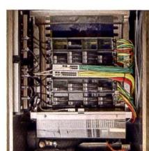
Heizung der Zukunft? Bei einem Pilotprojekt wurden in einem Basler Sechsfamilienhaus dezentrale Rechenmodule im Keller installiert. Ihre Abwärme wird über ein Ölbad zur Wärmeproduktion genutzt.
