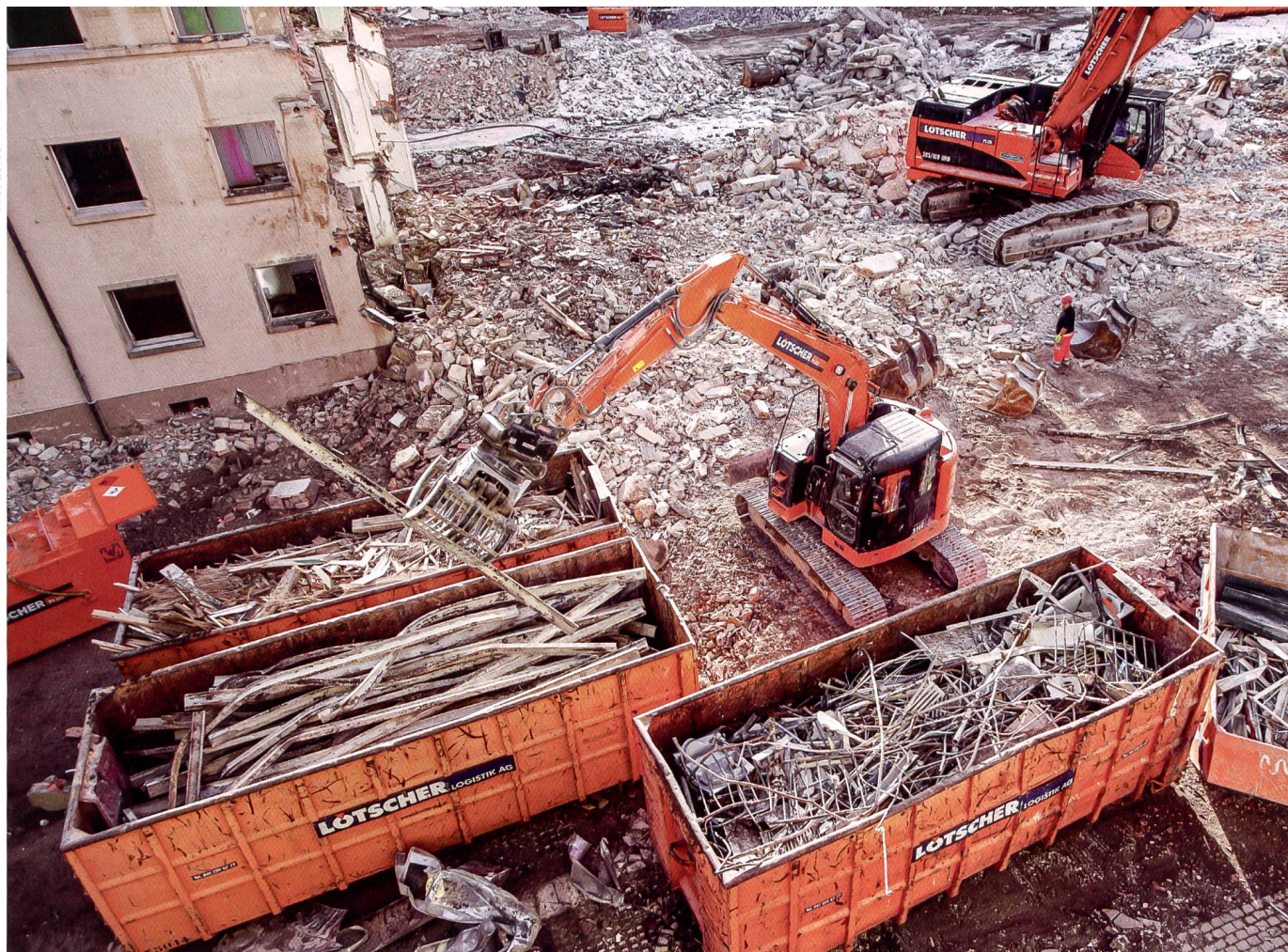
Das Sortieren der vielen Baustoffe und -teile, die beim Abbruch anfallen, ist aufwendig. Bild: Triage beim Rückbau der Siedlung Himmelrich 3 der Allgemeinen Baugenossenschaft Luzern (ABL). Wohnen hat die Neubauten in der Ausgabe 5/2020 ausführlich vorgestellt.
