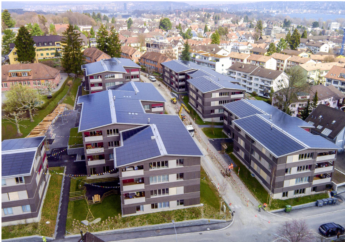
Die Photovoltaikanlage auf den Dächern der Neubausiedlung Balberstrasse in Zürich produziert mehr Strom, als die Bewohnerinnen und Bewohner vor Ort verbrauchen. Auf den fünf Häusern sind insgesamt 2428 Module mit einer Leistung von 558,4 kWp installiert (Bauträgerin: Allgemeine Baugenossenschaft Zürich, Anlage: PV-Montagesystem Indach Solrif®, Ernst Schweizer AG).
