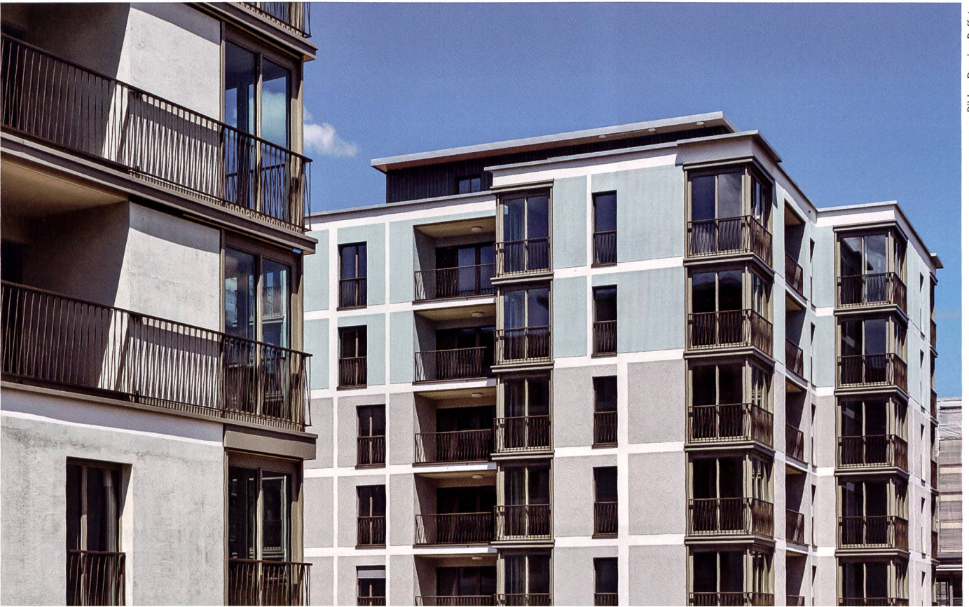
Duplex Architekten entwarfen für die fünf Häuser der BEP und die zwei Häuser der Sammelstiftung Nest ein einheitliches Erscheinungsbild.
