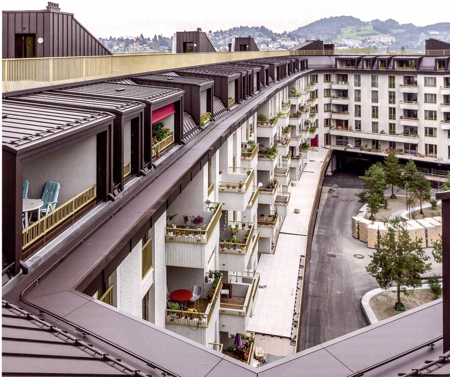
Blick in den Hof mit dem aluverkleideten Dachgeschoss und der durchlaufenden 300-Meter-Dachterrasse. Die Lukarnen bestehen aus vorfabrizierten Holzelementen.
