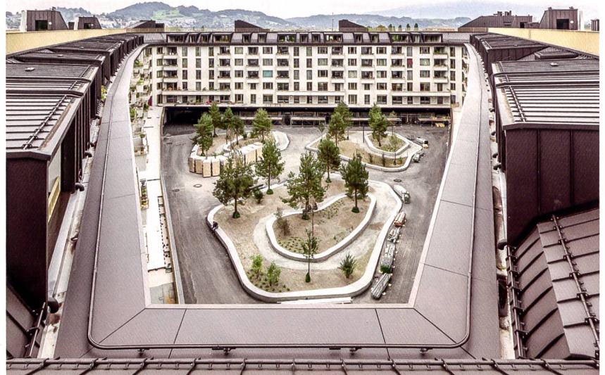
Wegen der darunterliegenden Einstellhalle ist der Wurzelraum für die Hofbepflanzung beschränkt. Der Landschaftsarchitekt setzte deshalb auf eine Bergflora – die drei Erhebungen nehmen darauf Bezug.
