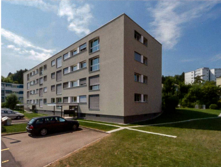
Gesamtsanierung MFH Am Brunnenbächli in Zollikerberg
