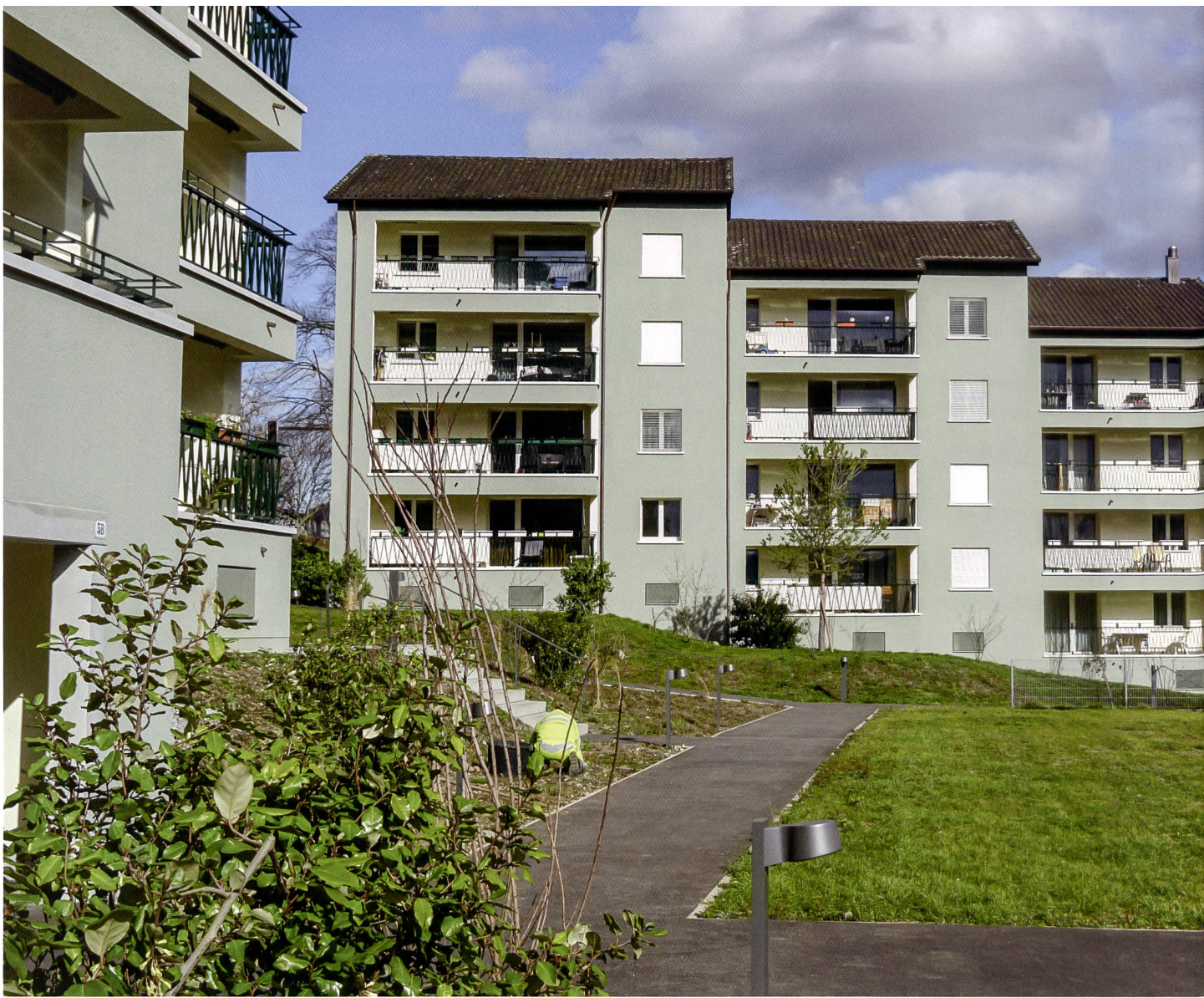
Die drei Mehrfamilienhäuser mit insgesamt 62 Wohnungen wurden von aussen zusätzlich gedämmt und erhielten einen neuen Anstrich.
