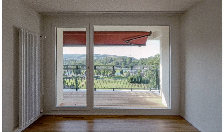
Der Balkon wurde leicht verbreitert. Dank neuer, offener Balkonbrüstung und raumhohen Fenstern gibt es mehr Licht in den Wohnungen.
