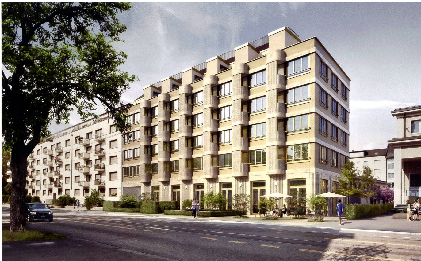
Beim Mehrfamilienhaus an der Hohlstrasse in Zürich setzte Architekt Dietrich Schwarz eine nur acht Zentimeter dicke hocheffiziente Aerogeldämmung ein.
