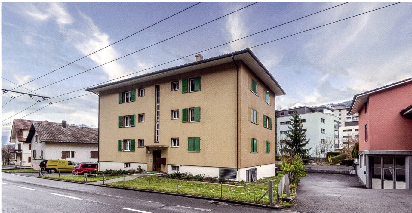
Die bestehende Dämmung des Gebäudes wurde belassen. Durch den Wechsel von Gas auf Umweltwärme hat sich der CO 2 -Ausstoss der Heizung auf null reduziert.
