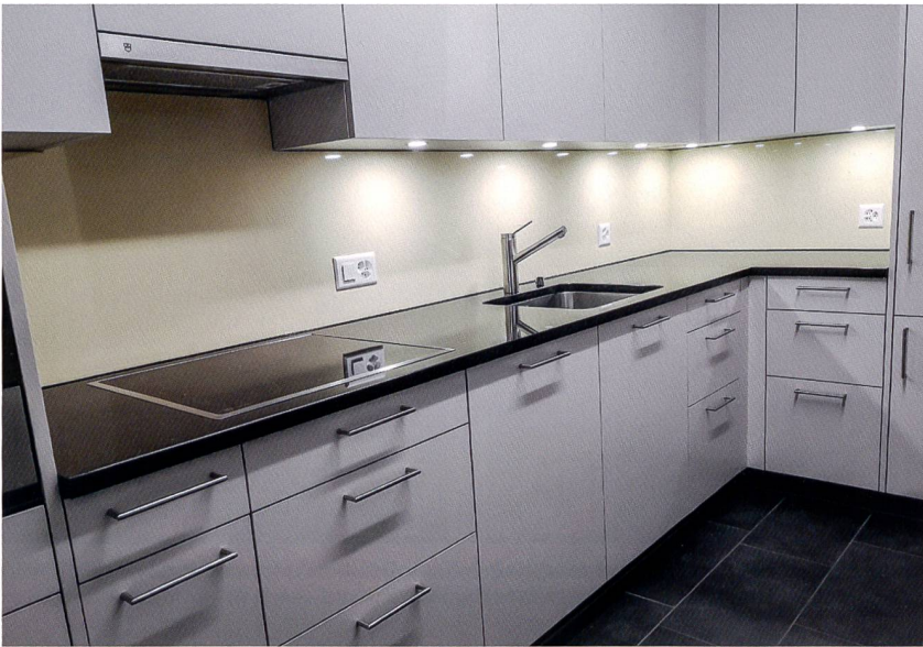
Küchenrenovation vorher-nachher bei der Baugenossenschaft Silu: Zum Einsatz kommen dauerhafte, leicht zu reinigende Materialien wie etwa die Granitabdeckung.
