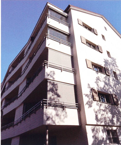
Das fünfgeschossige Gebäude an der Hegenheimerstrasse versah man mit einer neuen Balkonschicht. Neu sind alle Wohnungen vom Balkon her mit einem privaten Zugang zum neuen Lift erschlossen. Auf dem neu isolierten Dach erstreckt sich eine 675 Quadratmeter grosse Photovoltaikanlage.
