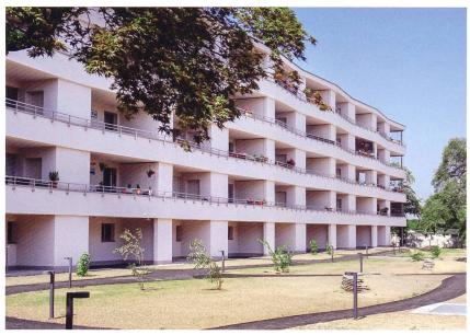
Das fünfgeschossige Gebäude an der Hegenheimerstrasse versah man mit einer neuen Balkonschicht. Neu sind alle Wohnungen vom Balkon her mit einem privaten Zugang zum neuen Lift erschlossen. Auf dem neu isolierten Dach erstreckt sich eine 675 Quadratmeter grosse Photovoltaikanlage.
