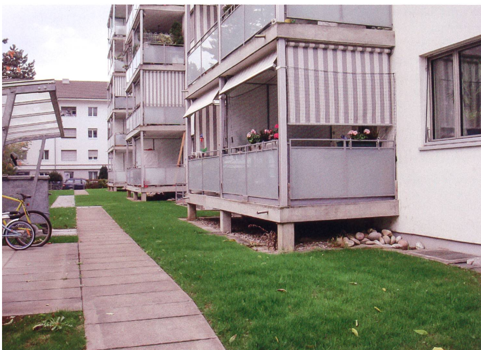
Bei der Liegenschaft Felsplattenstrasse ersetzte die WGB Lift und Fenster, sanierte das Dach und versah es mit einer Photovoltaikanlage.
