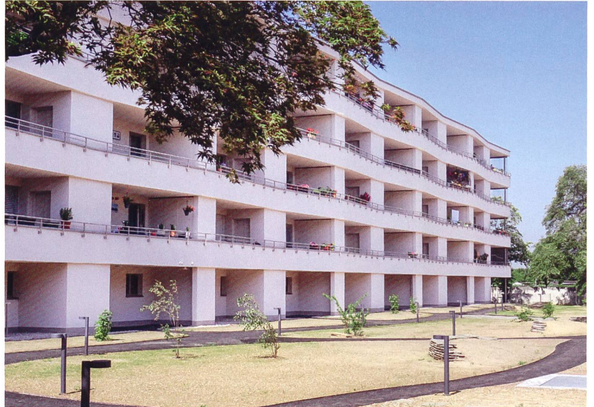
Das fünfgeschossige Gebäude an der Hegenheimerstrasse versah man mit einer neuen Balkonschicht. Neu sind alle Wohnungen vom Balkon her mit einem privaten Zugang zum neuen Lift erschlossen. Auf dem neu isolierten Dach erstreckt sich eine 675 Quadratmeter grosse Photovoltaikanlage.
