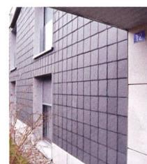
Vorgehängte hinterlüftete Fassaden sind eine dauerhafte Renovationslösung. Auch optisch kann man dabei Akzente setzen, so wie bei dieser Schieferverkleidung bei einer Siedlung der Gewo Züri Ost.
