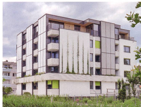
Das «Sonnenhaus» des Architekten Beat Kämpfen in Zürich Schwamendingen verfügt über PV-Anlagen auf dem Dach und thermische Kollektoren an den Fassaden. Die solar erzeugte Wärme wird in riesigen Tanks gespeichert. Der Versorgungsgrad solcher Häuser beträgt 70 bis 100 Prozent.
