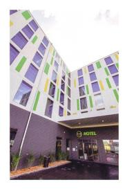
Das «B&B Airport Hotel» in Rümlang wurde von A bis Z mit Hilfe von BIM geplant und gebaut. Die 18 Steigzonen kamen als 18 Meter lange Module vorgefertigt auf die Baustelle und waren innert 15 Minuten eingebaut.
