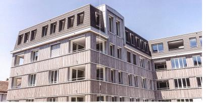
Die Fassadenverkleidung besteht aus vorvergraute Weisstanne.
