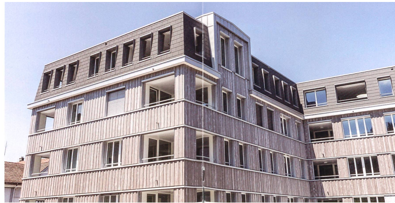
Die Fassadenverkleidung besteht aus vorvergrauter Weisstanne.
