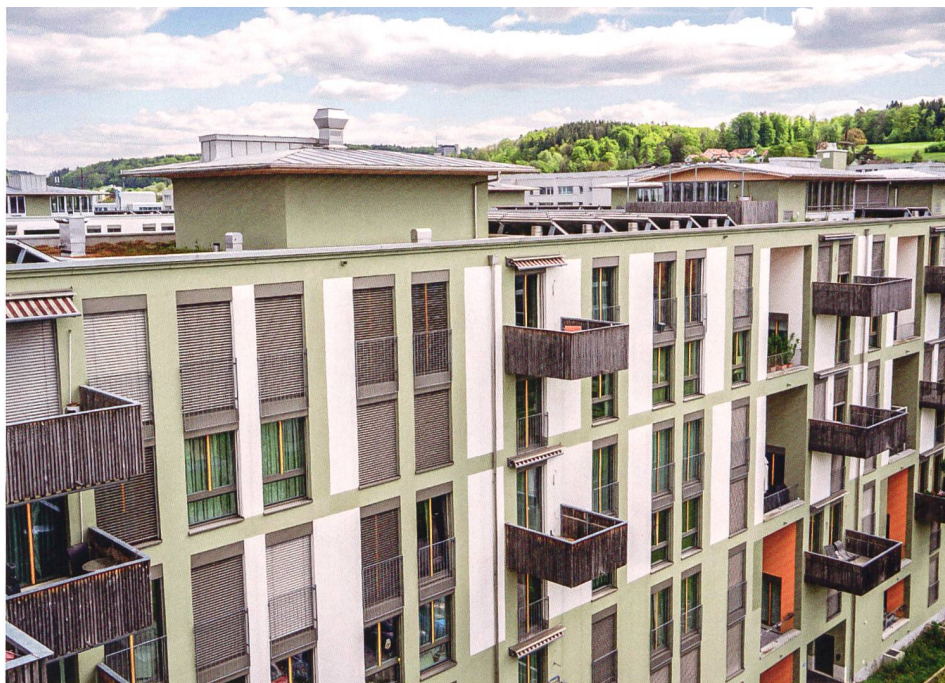
Von aussen sieht man der Siedlung nicht an, dass ihre beiden Teile verschiedenen Genossenschaften gehören – und über eine andere Lüftungstechnik verfügen.
