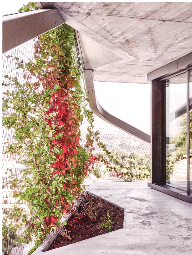
Beispiel einer modernen Fassadenbegrünung: der «Garden Tower» in Wabern (BE). Die Pflanztröge sind in die gebäudeumlaufenden Betonplatten integriert, die Pflanzen wachsen entlang der Metallgitter und beschatten die Wohnungen.
