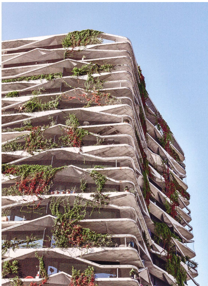
Beispiel einer modernen Fassadenbegrünung: der «Garden Tower» in Wabern (BE). Die Pflanztröge sind in die gebäudeumlaufenden Betonplatten integriert, die Pflanzen wachsen entlang der Metallgitter und beschatten die Wohnungen.
