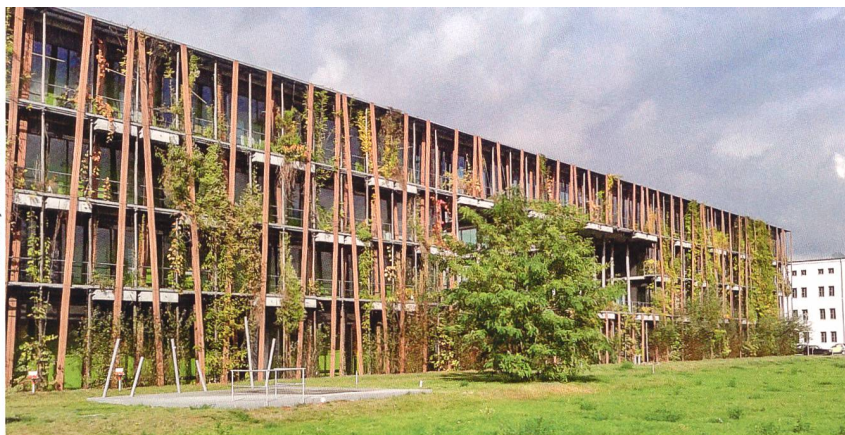
1 Eine gelungene Mischform aus bodengebundener und fassadengebundener Begrünung in Trögen findet sich bei der Humboldt-Universität zu Berlin in Adlershof. Die Pflanzen unterstützen den sommerlichen Wärmeschutz.
