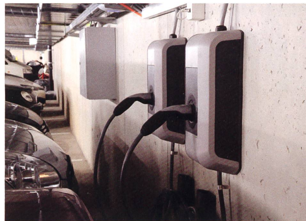
In der «Teiggi» sind auch die Photovoltaikanlage oder die Ladestationen für Elektrofahrzeuge ins Leitsystem eingebunden.
