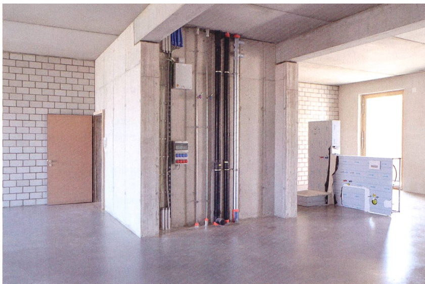
Die Künstlerinnen und Künstler übernehmen die Ateliers ohne jegliche Innenausstattung. Der Sanitär- und Küchenblock lässt sich frei bewegen und über einen Schlauch an der Decke an die Leitungsstränge anschliessen.
