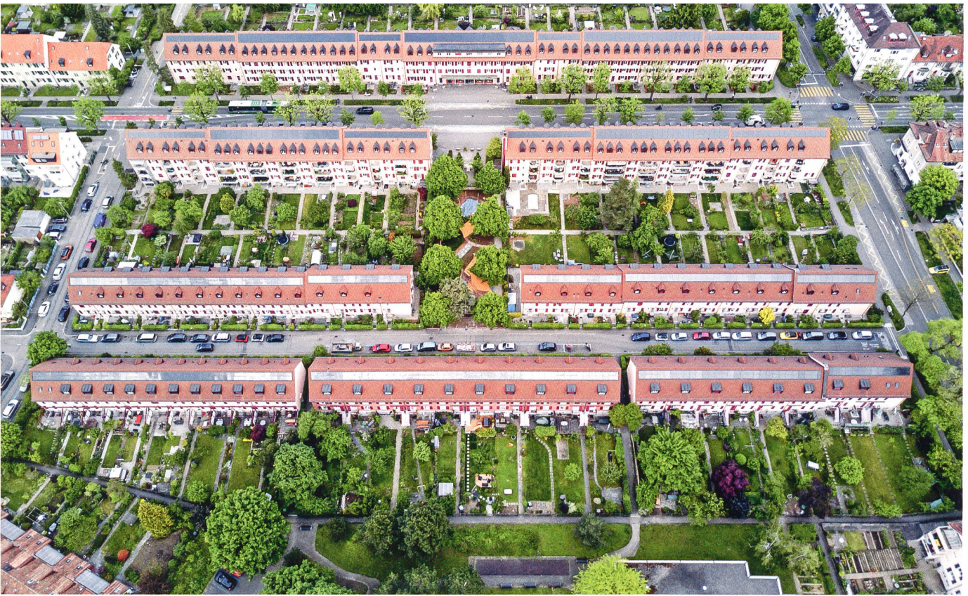
Die Wohngenossenschaft Im langen Loh aus der Luft: vorne die Reiheneinfamilienhäuser, hinten die Mehrfamilienhäuser.
