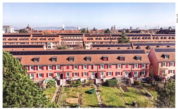
Die Einfamilienhäuser nach der Sanierung mit der Photovoltaikanlage auf dem Dach sowie den neuen Gauben.
